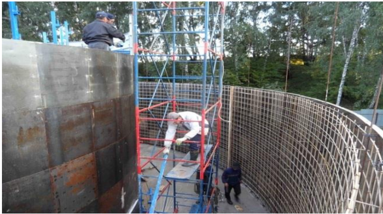
Čističky odpadních vod
