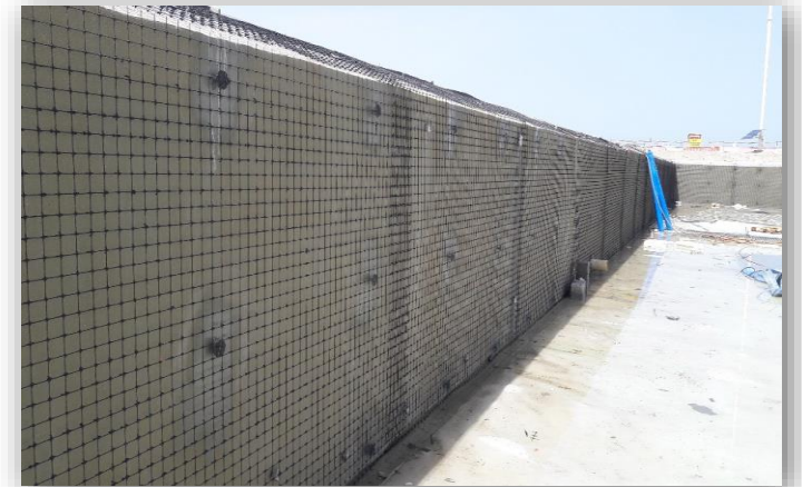
Vyztužení bazénu v kombinaci s kom. hmoždinkami
